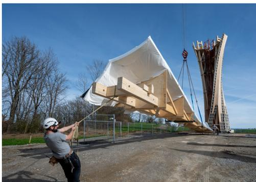
Errichtung der BSP-Tragstruktur des Wangen Turms
