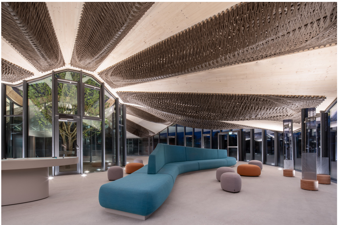
Hybrid-Flachs Pavillon, Innenansicht der wellenförmigen Hybriddachkonstruktion aus Brettsperrholzplatten und maschinell gewickelten Flachsfaserkörpern © ICD/ITKE/IntCDC University of Stuttgart
