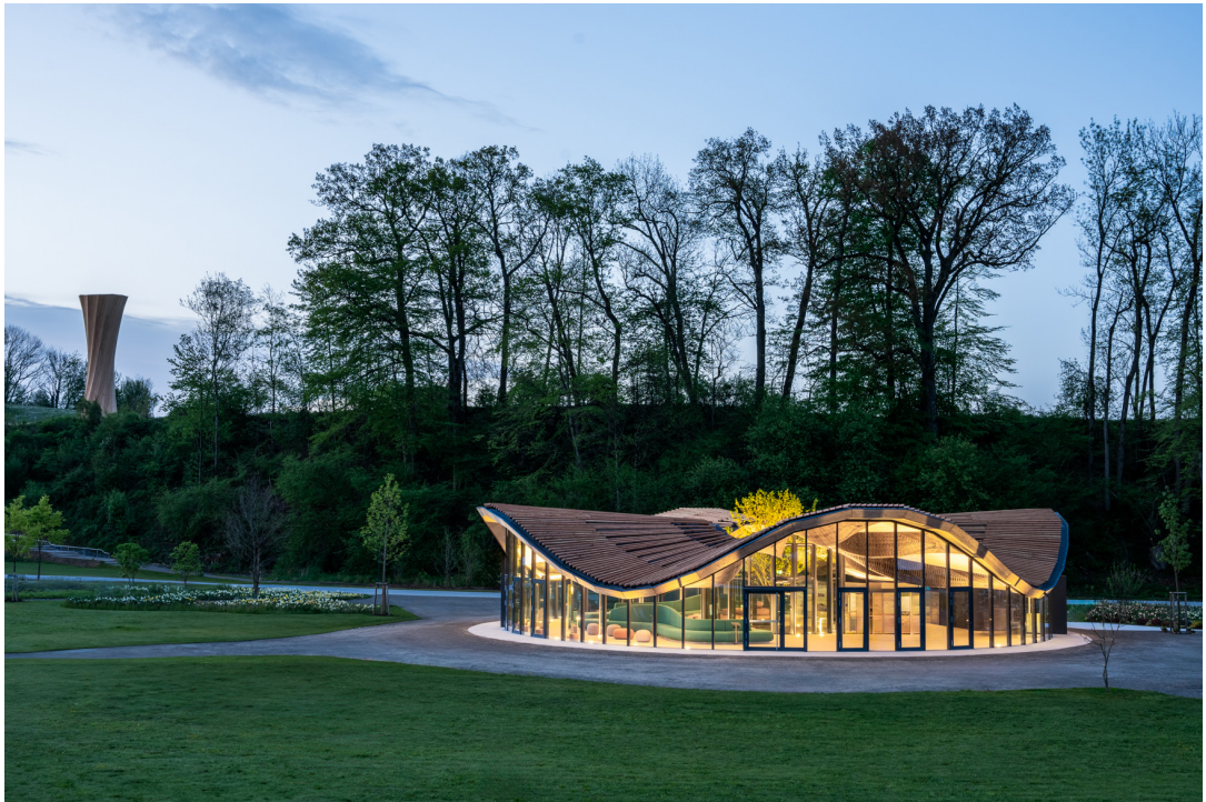
Hybrid-Flachs Pavillon, Außenansicht © ICD/ITKE/IntCDC University of Stuttgart
