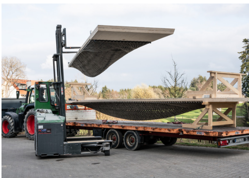
Transport der montierten, vorgefertigten Hybrid-Bauteile
