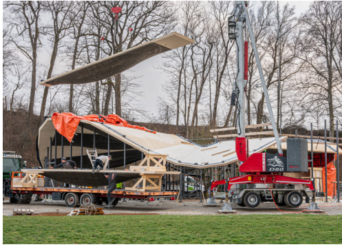
Montage des Hybrid-Flachs Pavillons auf der Baustelle
